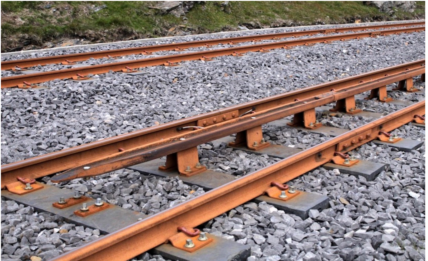
Détail du rail Fell
