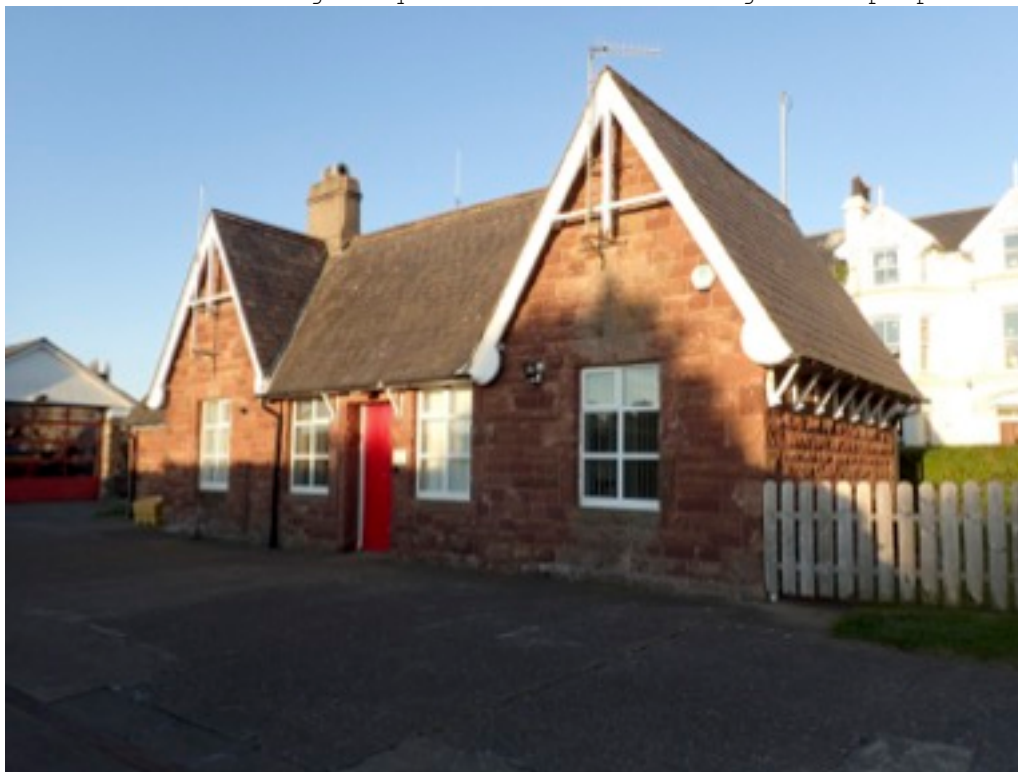
Kirk Michael : la gare qui est devenue le hangar des pompiers...
