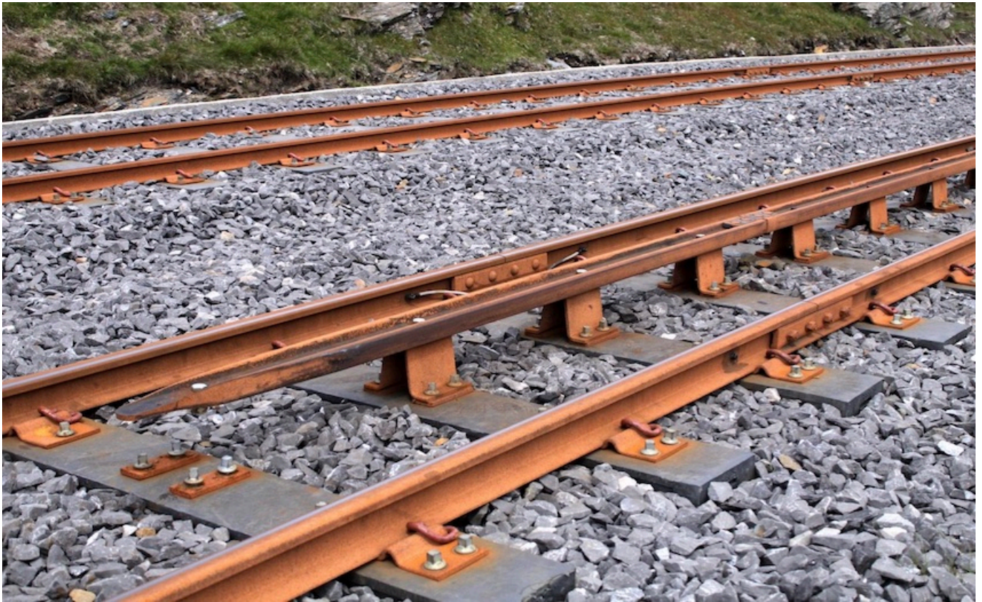
Détail du rail Fell
