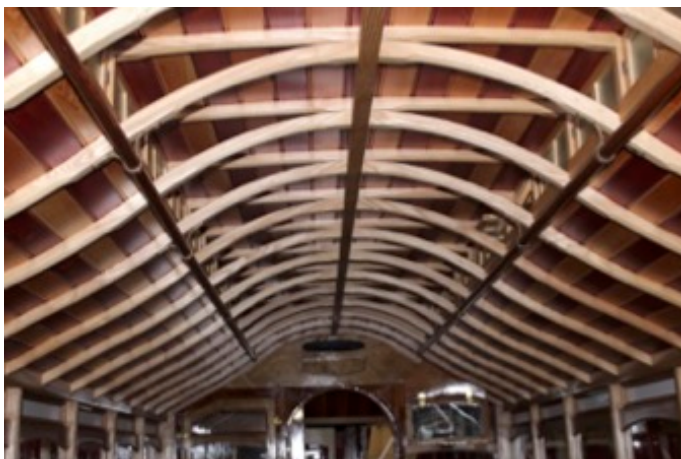
Détail du toit d'une voiture en cours de reconstruction.
